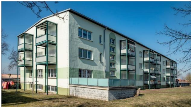
Revêtement de façade de 28 immeubles d'appartements, 1998 à 2009.
